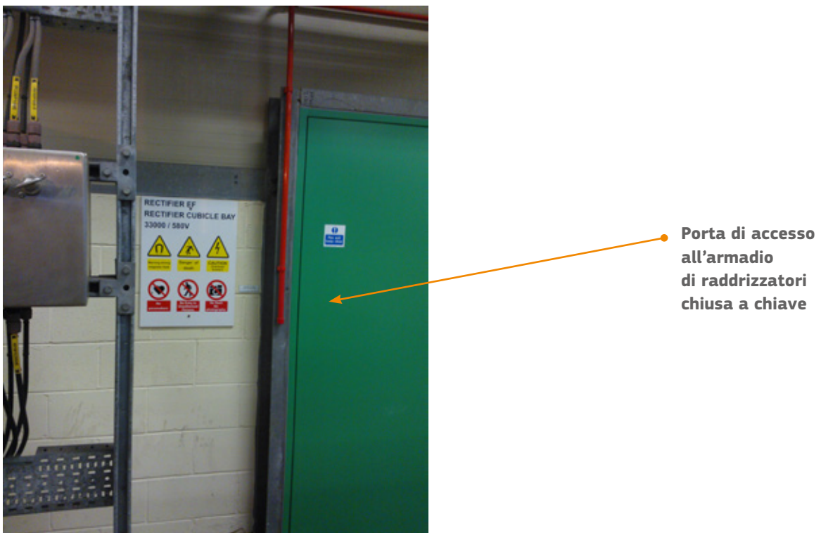
Figura 3.3 — Limitazione dell'accesso a una zona di armadi di raddrizzatori
